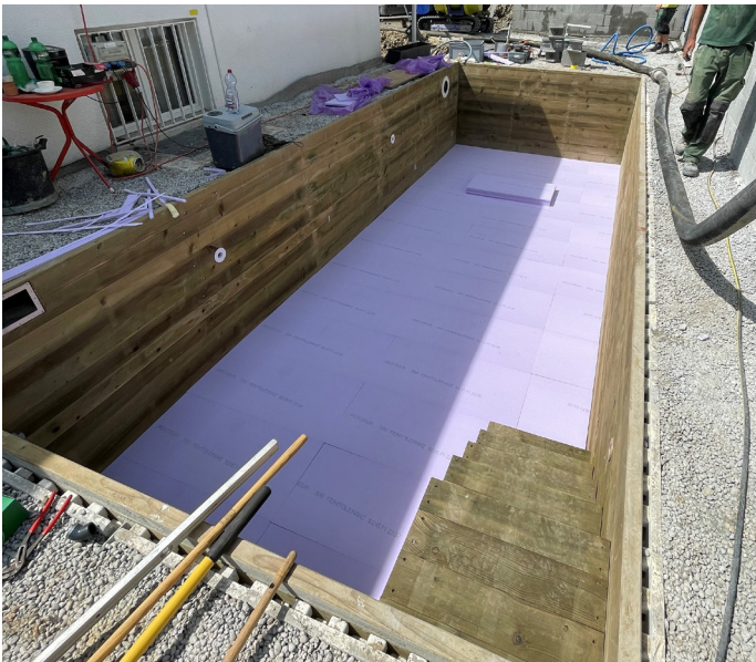
Bild 1) Fertig ertsellter Boden bereit für die Aukleidung mit Folie
