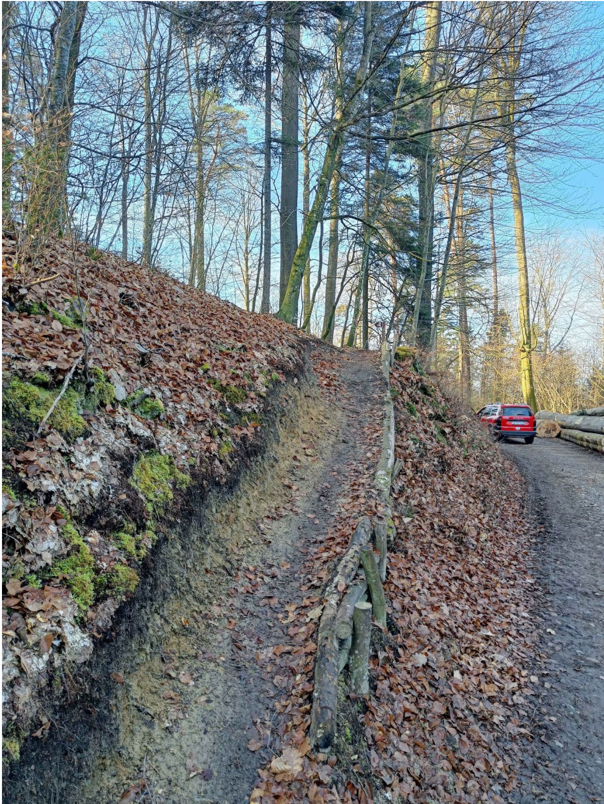
Abbildung 1: Erdverschiebung bis 40 cm aus Lokalmaterial für die Einmündung auf eine Waldstrasse.
